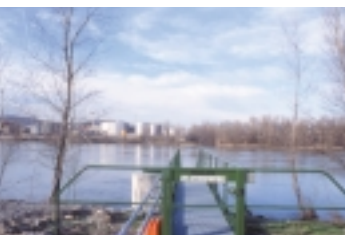
Station de surveillance à Ternay
